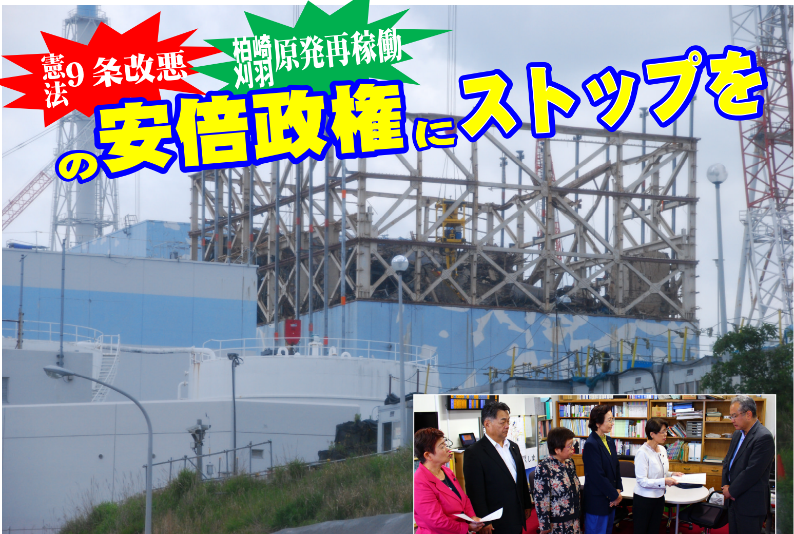
がれき撤去作業中の福島第一原発建屋 ＝6月8日共産党県議団視察
